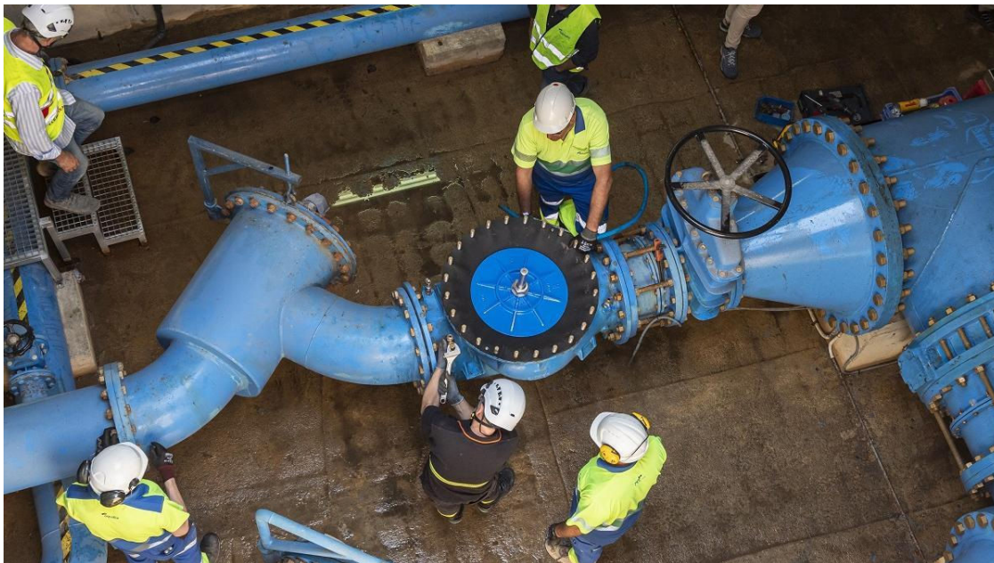
Unos operarios reparan una fuga en una tubería. / Aqualia
